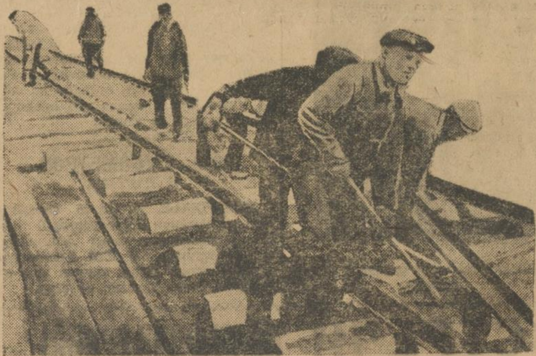
ВИЗ. Комсомольцы жел.-дорожной ячейки прокладывают узкоколейку.
