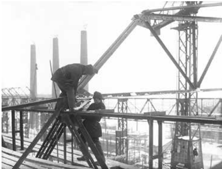
Рабочие-клепальщики на монтаже металлоконструкций цехов Уралмашзавода. 1930 г. Фото Н. К. Татарченко
