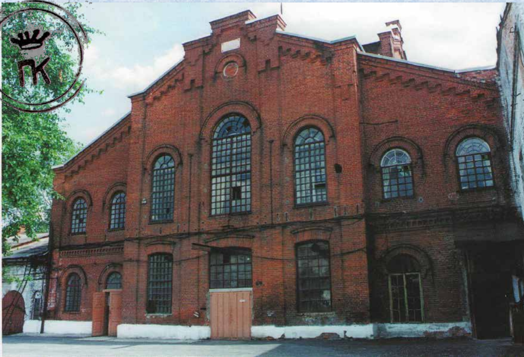
Здание цеха ректификации. Образец производственной архитектуры XIX века
